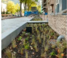
Infiltratiestroken met bovengrondse opslag
