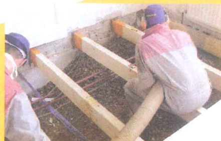
Schelpenisolatie bij renovatie
