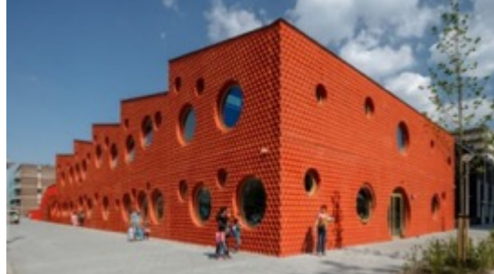
Energie neutrale IKC Zeven Zeeën
